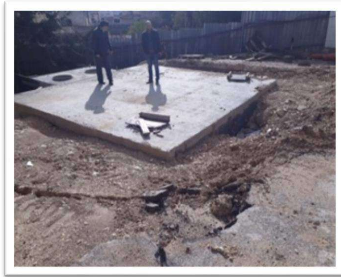
صورة رقم (16): خزان التوازن مصنع الصفا للالبان
